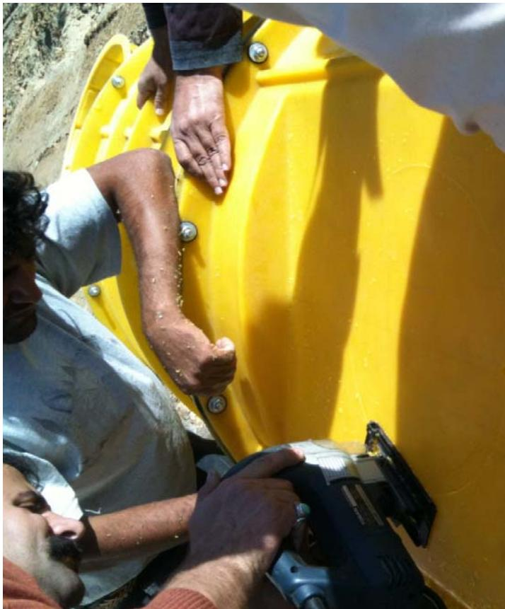
روش اتصال لوله تک جداره به منهول پلی اتیلن (ورودی منهول)
