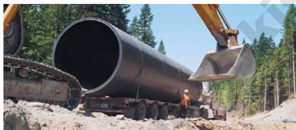
شکل (9)- نمونه نحوه حمل لوله پلی اتیلن
