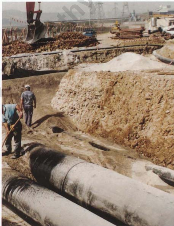
شکل 9.5 جهت تامین آب خنک کننده نیروگاه برق قرضه(فلسطین)
